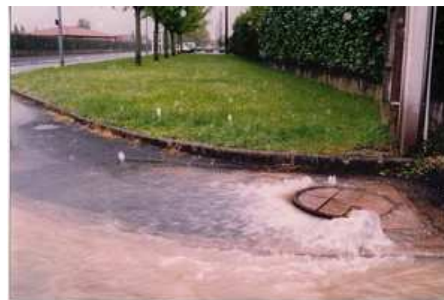
Débordement du réseau d'évacuation des eaux
