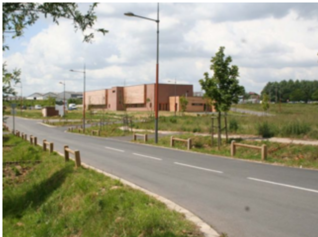
Plate-forme multi-services de Tincques - Vitrine de l'éco-construction
