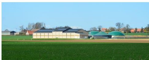
Vue extérieure de l'unité de méthanisation
